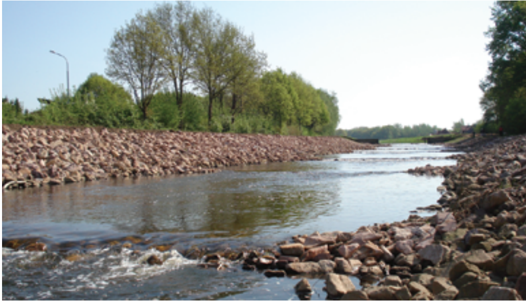
Fig. 6.3 Cascade vispassage.
